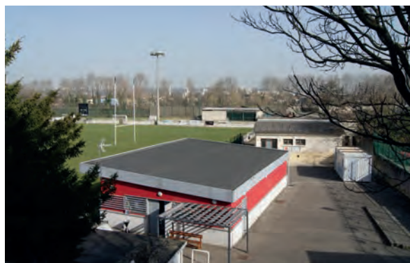
Vue des deux bâtiments constituant le P.H.A.Re. Au premier plan la salle avec le bar, l'épicerie, le bureau des AS, la boutique. Au second plan : les douches, les sanitaires et la buanderie.
