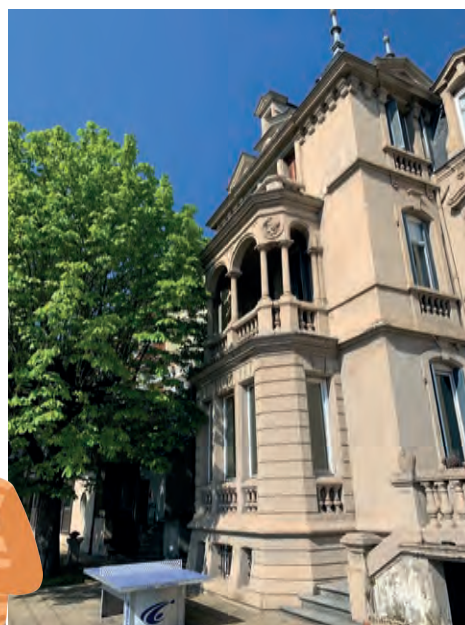
Vue de la Montée Saint-Laurent depuis la cour.
