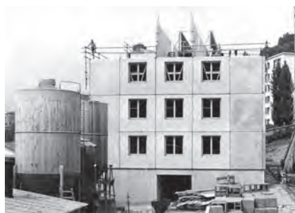
En haut : première cité pour familles (La Mulatière) - 1954 En bas : Construction de 80 logements de type HLM, d'ateliers éducatifs et d'un gymnase (La Rochette) - 1971
