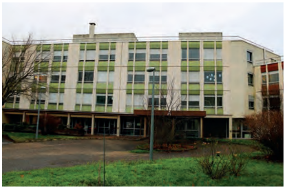
Vue d'une des façades de l'ancien hôpital Charial.
