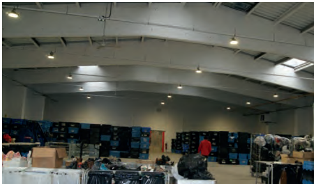
La salle de tri du chantier d'insertion de Décines.
