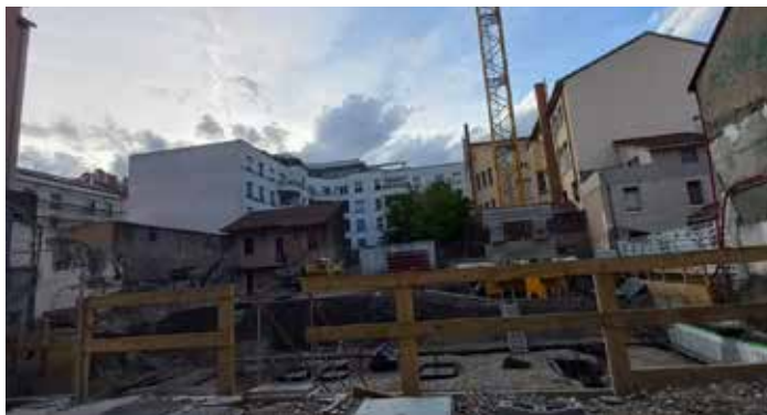
Travaux en juin / novembre 2022
