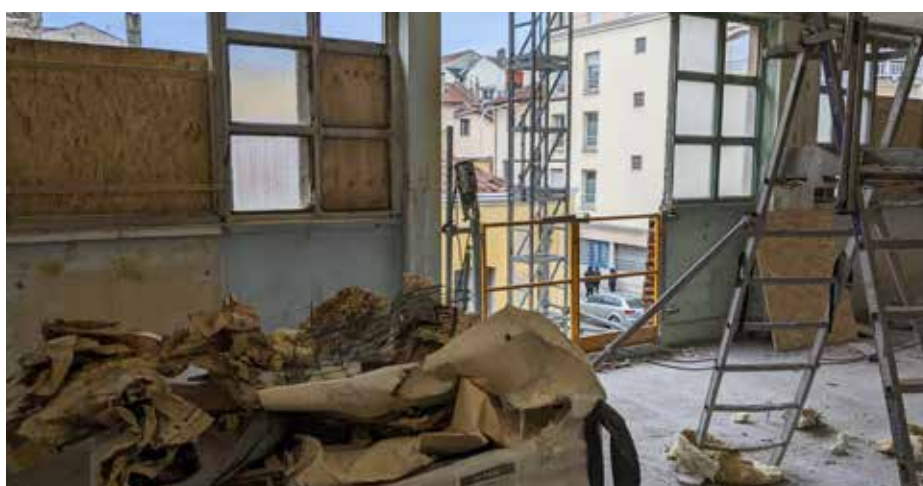
Démolition des cabines
