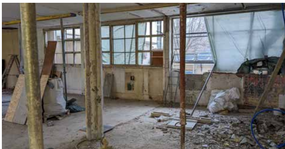
Démolition des cabines
