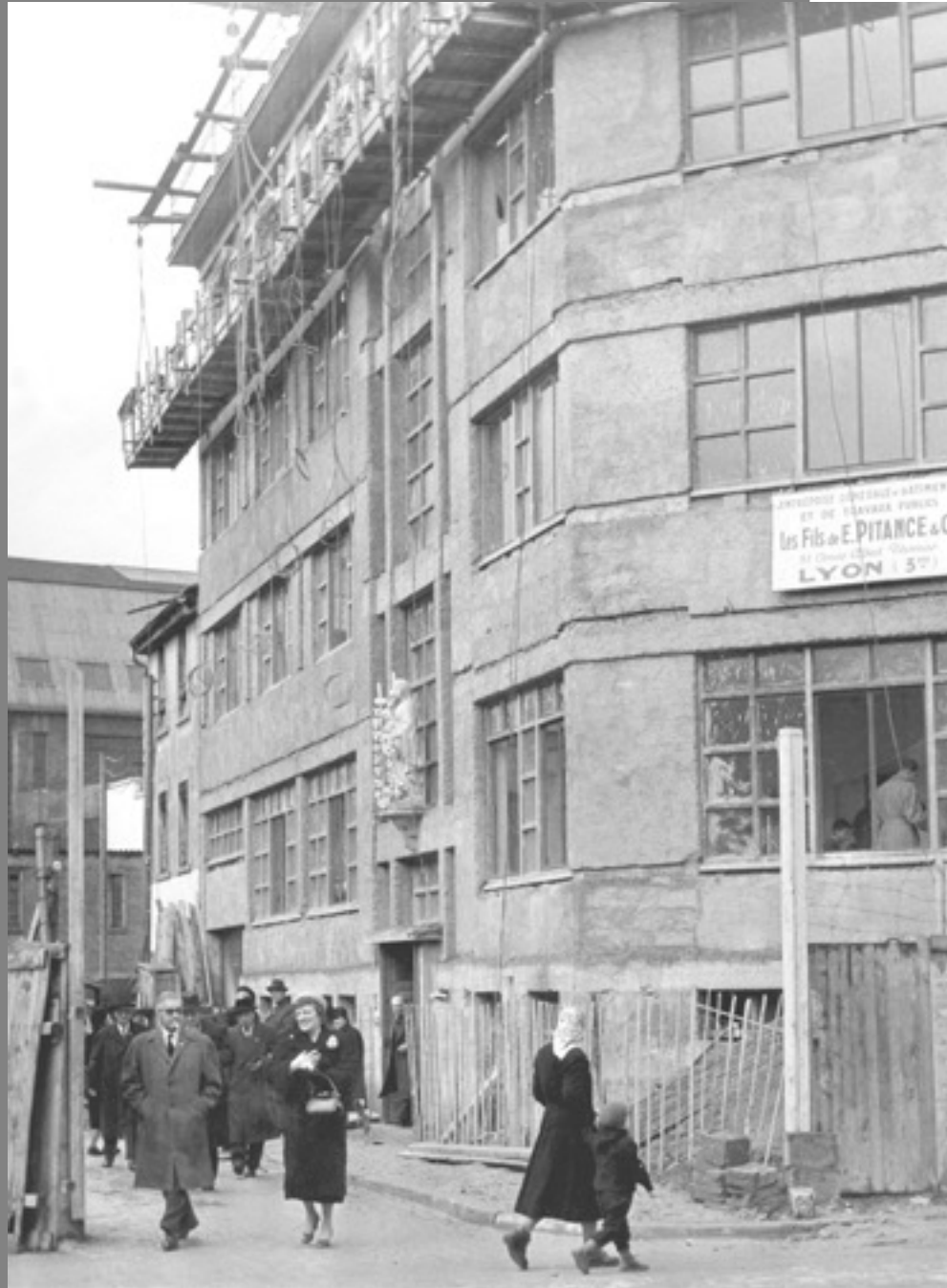
TRAVAUX RUE DUMOULIN EN 1957
