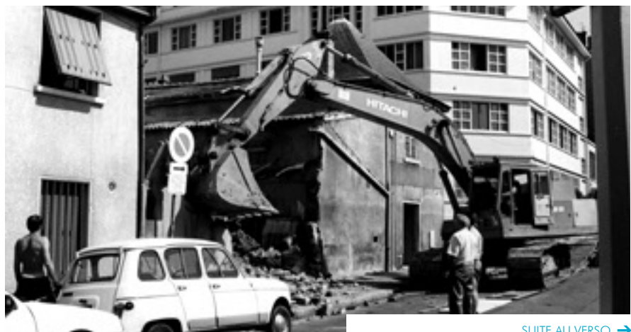
DEMOLITION DU 43 RUE CLUZAN DEVANT LE 3 RUE PÈRE CHEVRIER AFIN D'INSTALLER DES CONSTRUCTIONS MODULAIRES - 1990
