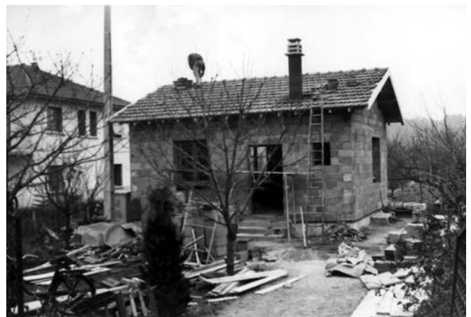
« 1972, construction en dur sur les fondations du chalet »
