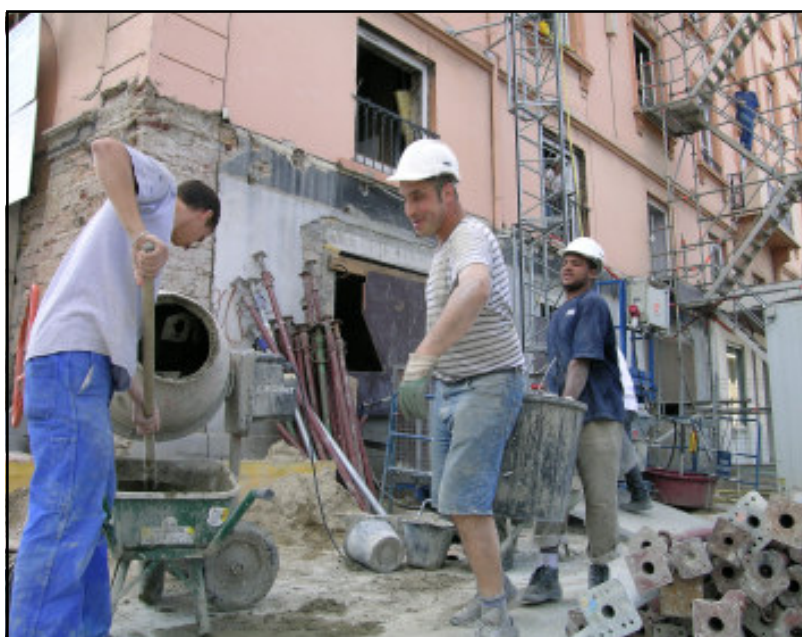
Un grand chantier pour des travaux incontournables de sécurité ...
